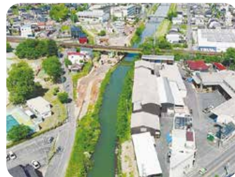
境川河川改修 (JR 橋梁)
