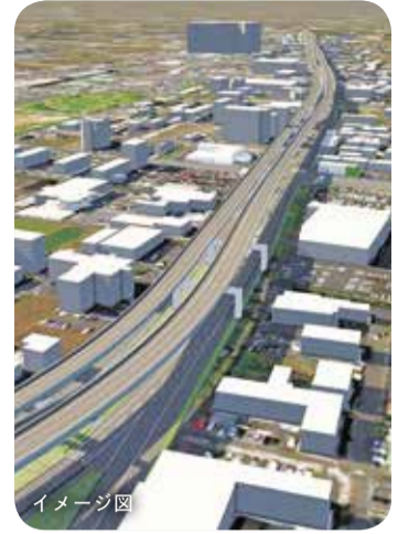
国道21号線の岐阜市内立体化
